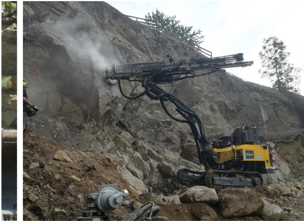
■ **Perforazione con crawler Epiroc per la realizzazione degli ancoraggi**
