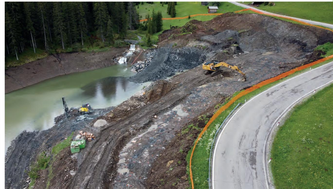
350 ml di perforazione al giorno su batterie di fori subverticali diametro 75 mm che presentavano lunghezza compresa fra 8 e 14 m dal piano campagna. La presenza di un carosello con scambiatore di aste ha permesso la realizzazione anche dei fori più profondi senza necessità di intervento
