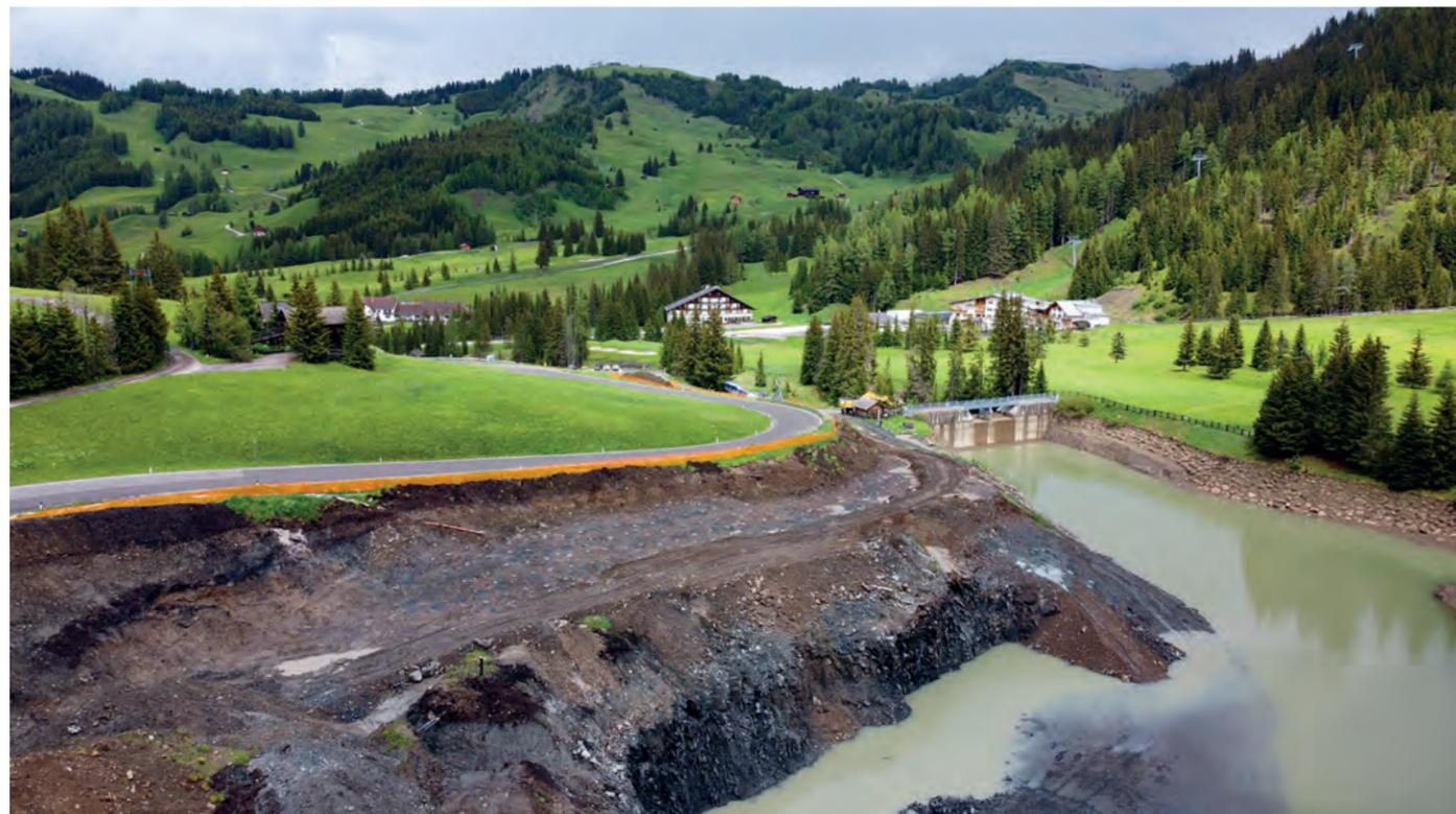
GPS trimble ha eseguito la rifinitura dello scavo e la profilatura del terreno secondo le indicazioni di progetto provvedendo in completa autonomia, senza bisogno di supporto topografico dall'esterno, alla profilatura di scarpate anche molto articolate. La movimentazione del materiale in can-
