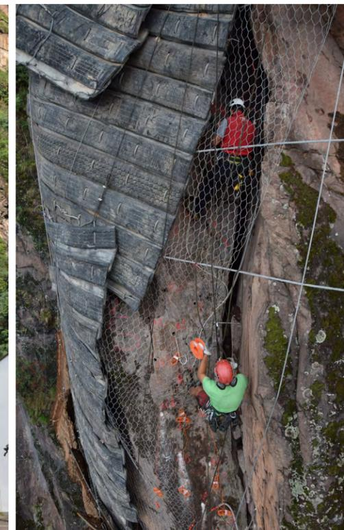
LA PARTICOLARE COLLOCAZIONE DEL CANTIERE E L'ELEVATA COMPLESSITÀ DELLE LAVORAZIONI DI MESSA IN SICUREZZA DELL'AMMASSO ROCCIOSO DEGRADATO HANNO RICHIESTO INTERVENTI ATTIVI DI CHIODATURA E RIVESTIMENTO DELLA PARETE, NONCHÉ UN INTERVENTO DI DEMOLIZIONE CONTROLLATA
