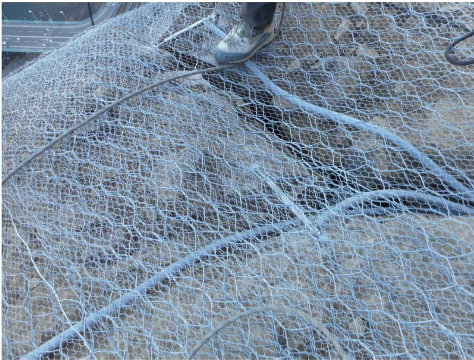
Fig. 4. Particolare degli estensimetri a barra Fe3 e Fe4 al termine della posa della rete a doppia torsione.
