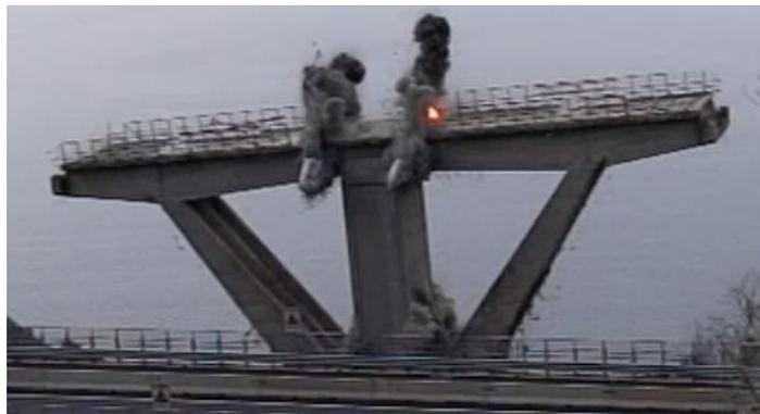
*Fig. 5.5: Momento dell'ultimo scoppio (+433 ms dal primo): teoricamente i tre detonatori (tutti del tempo 20 della serie DED da 250 ms) dovevano detonare nello stesso istante; invece, come si vede dalle tre immagini, le detonazioni avvengono in momenti differenti ed al di fuori della tolleranza  $\pm 50\%$  del proprio ritardo nominale.*
