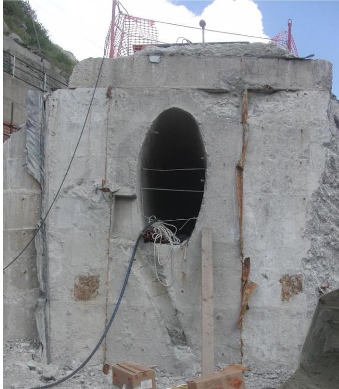
Fig. 4.6: Il cunicolo d'ispezione presente all'interno della diga
