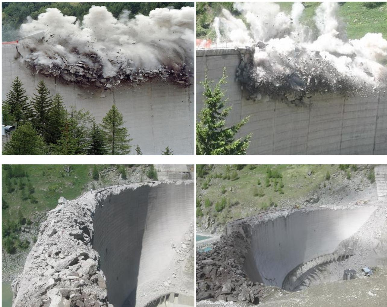
*Fig. 5.1: Due volate con relative pezzature*
