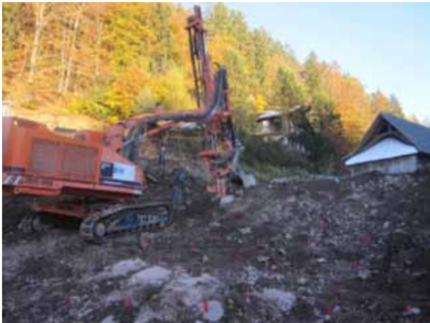
Foto 4 - Preparazione di una volata
