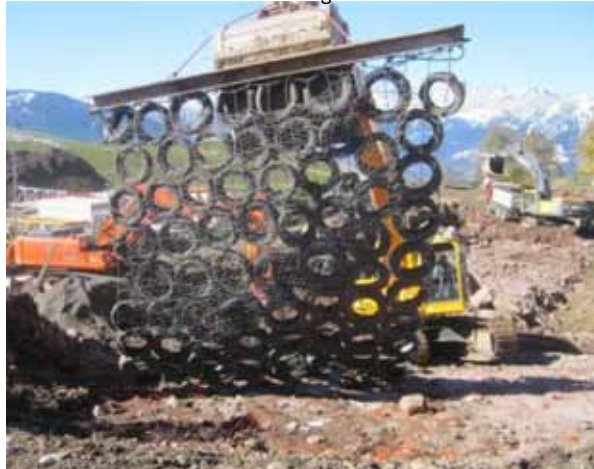
Foto 5 - Reti di protezione in primo piano si riconoscono i detonatori ad onda d'urto collegati
