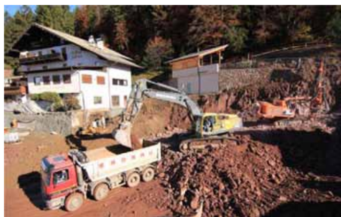
Foto 2 e 3 Fasi di perforazione e smarino riscontri vibrometrici volata riscontri vibrometrici del martellone idraulico
