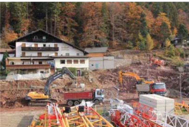
Foto 1 - panoramica sull'area di intervento
