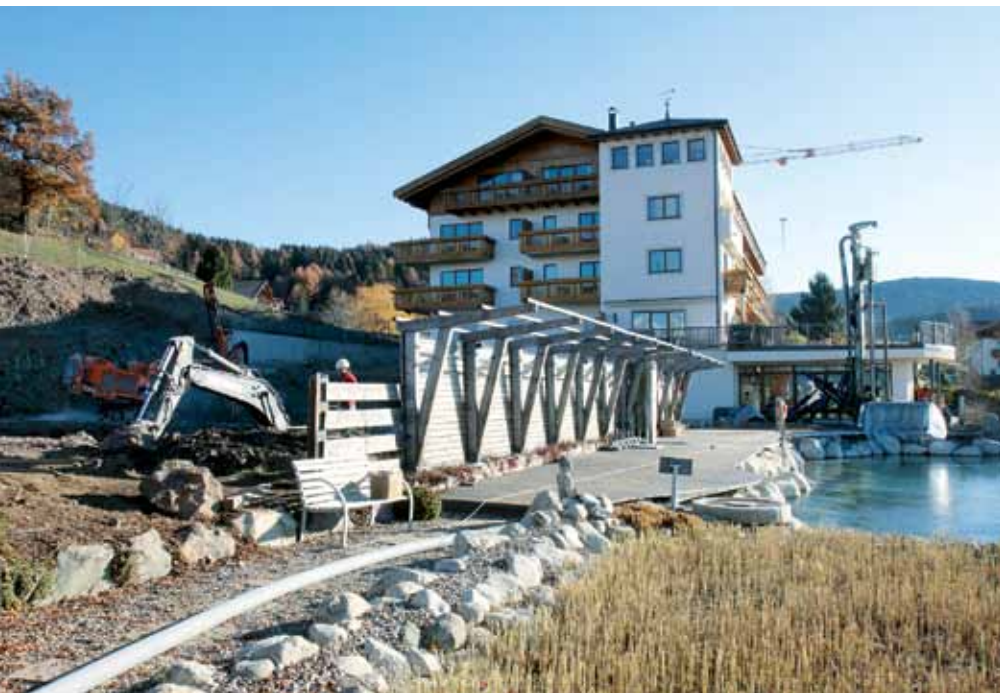
Foto lavorazioni affiancate di escavatore, preparazione di una volata e realizzazione di micropali
