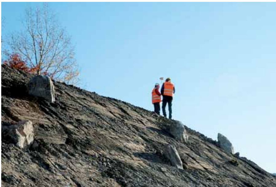
Foto verifica della corretta esecuzione di un nuovo rilevato
