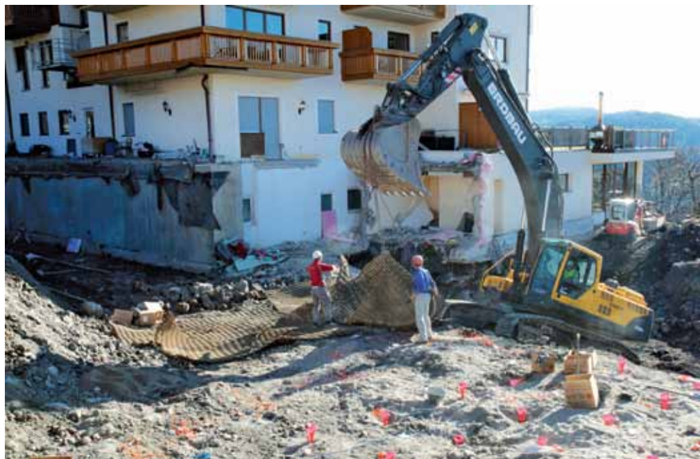
Foto predisposizione dei blasting mats prima di procedere al brillamento di una volata
