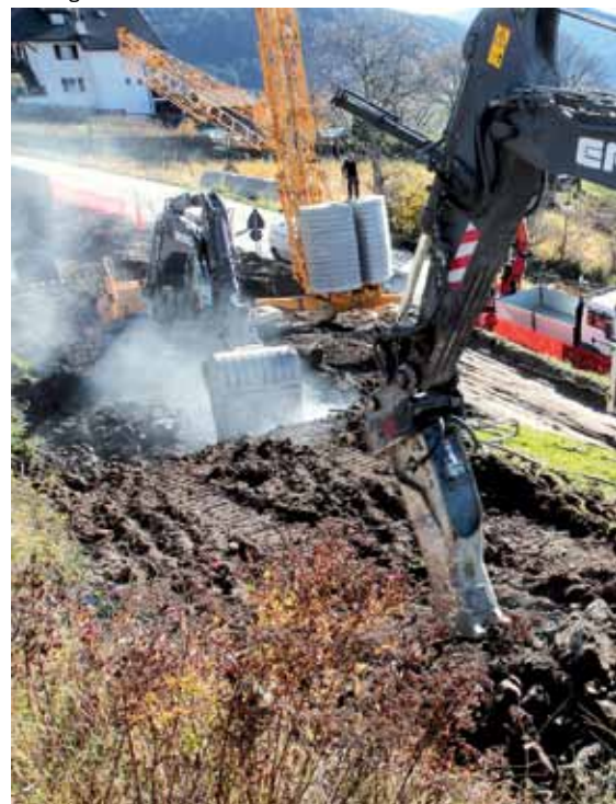
Foto fase di scavo che si allontana dalla zona già completata dove è quasi pronta una gru
