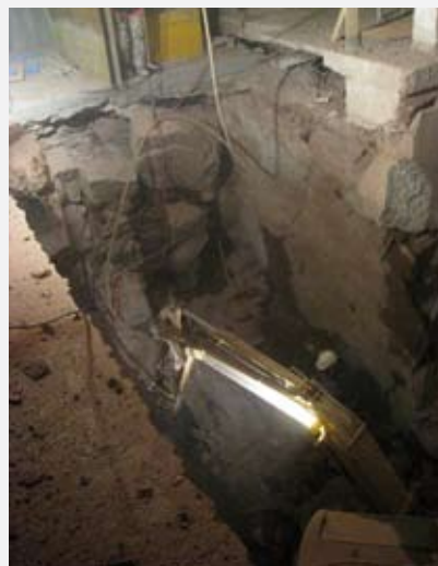
5. momenti dello scavo
