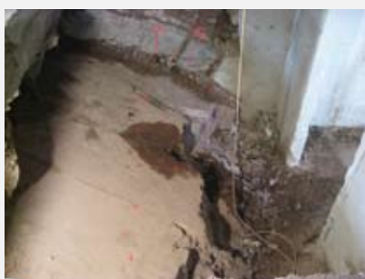
2. ammasso roccioso prima dello sbancamento
