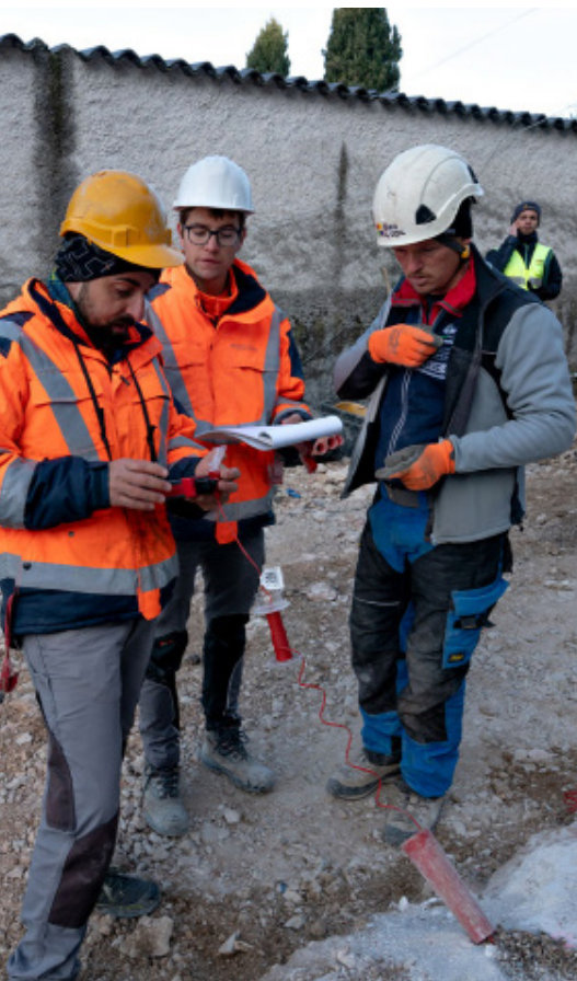
■ Programmazione detonatori elettronici con logger
