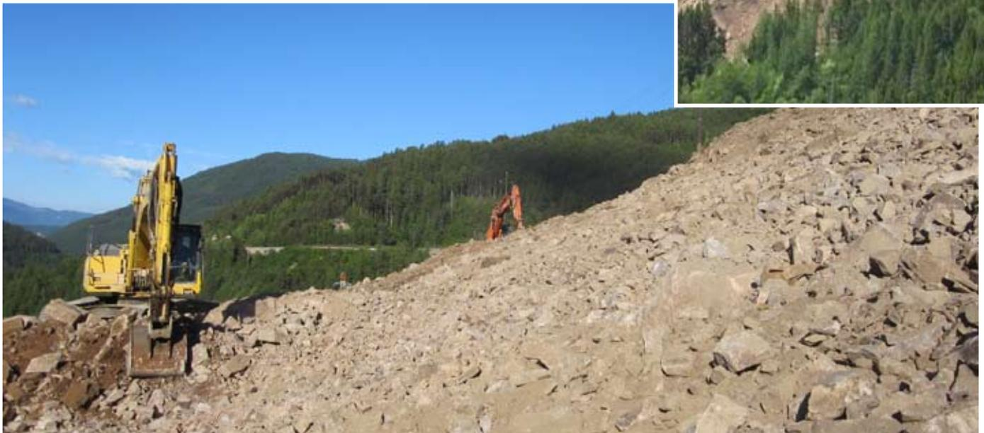
previsto l'uso lungo il foro della miccia detonante da 20 gr/ml mentre i fori verticali sono stati caricati direttamente con detonatore ad onda d'urto a fondoforo. Il borraggio dei fori orizzontali è stato eseguito con sacchetti di sabbia allo scopo preparati, il tratto di foro non caricato nei fori verticali è stato invece riempito direttamente con l'inerte di perforazione.
