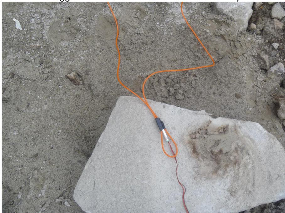
*fissaggio del detonatore elettrico al tubo ad onda d'urto*
