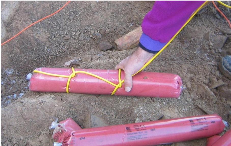
*Miccia detonante infilata assialmente nella cartuccia fissata con doppio nodo lungo la cartuccia*
