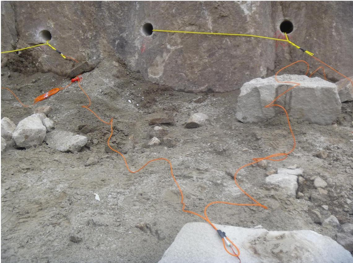
*Esempio di uso: il detonatore elettrico in primo piano attiva il primo tubicino del detonatore, dopo 25 ms detonerà la connessione attivando il successivo tubicino. Il primo detonatore fissato alla miccia detonante in foto detonerà 500 ms dopo l'attivazione del detonatore elettrico, il secondo sarà sfalsato dal primo di 25 ms.*
