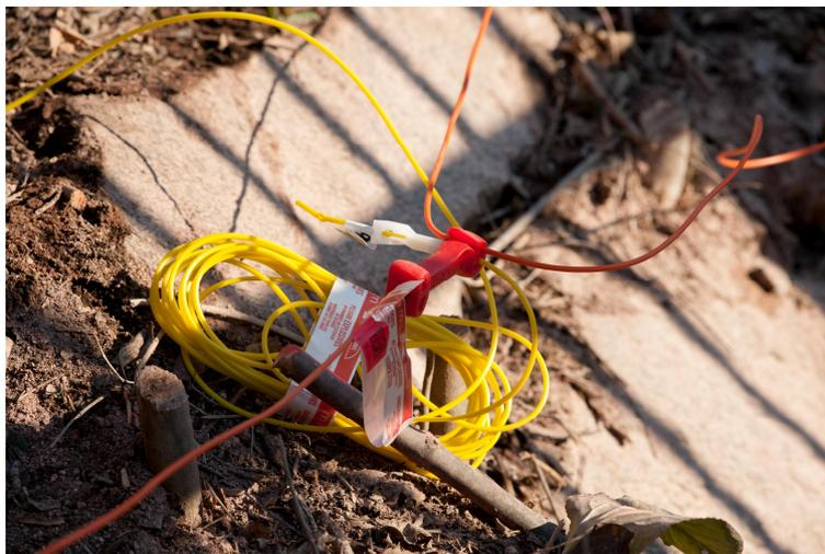
*Sistema di collegamento: sopra: il connettore viene fissato al tubicino del detonatore successivo
