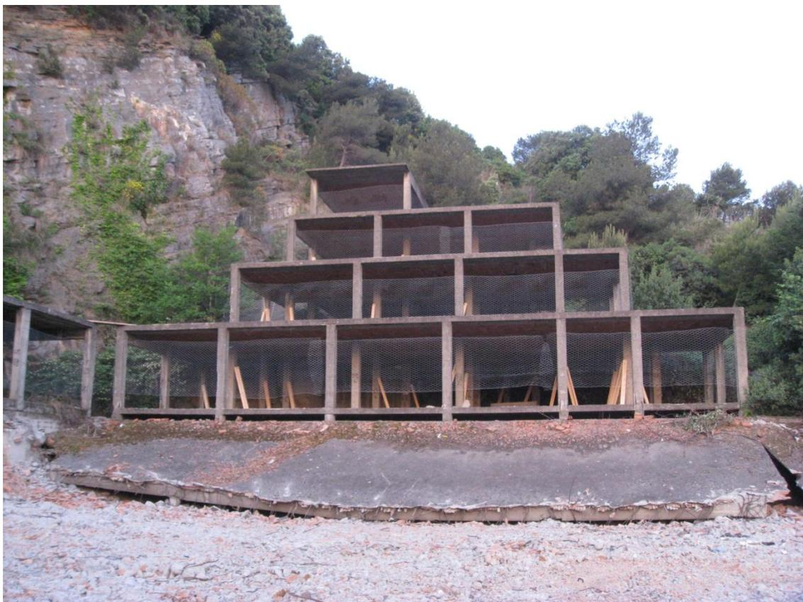
La struttura era costituita da uno scheletro di pilastri in cls e solai sempre in cls. Non sono presenti vani scale o vani ascensori quindi la struttura da demolire si presenta semplice. La demolizione deve prevedere il collasso della struttura ottenibile interessando esclusivamente i pilastri che devono essere %cernierati+almeno in tre punti per avere la certezza di garantire il collasso ottimale della struttura.
