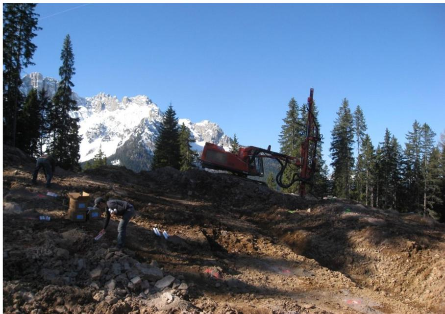
*Perforazione con sonda idraulica sullo sfondo e preparazione delle cariche in primo piano*
