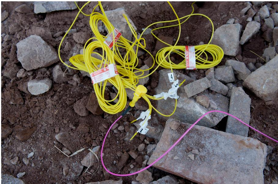
*Esempio di raggruppamento di più tubicini di differenti detonatori ad un unico morsetto di connessione*
