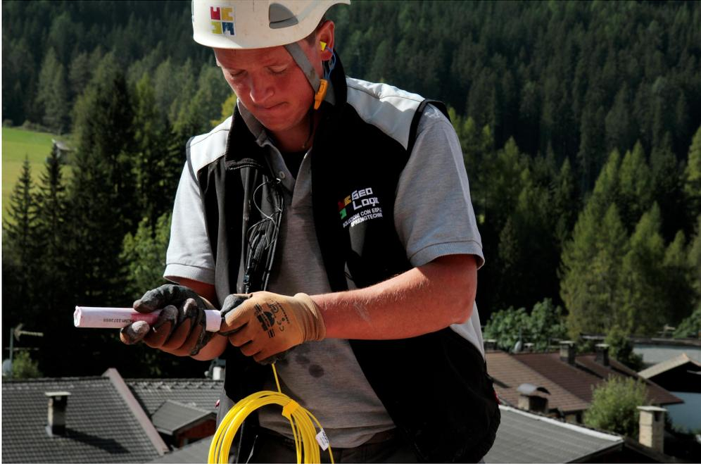
*Detonatore ad onda d'urto infilato assialmente alla cartuccia di dinamite*
