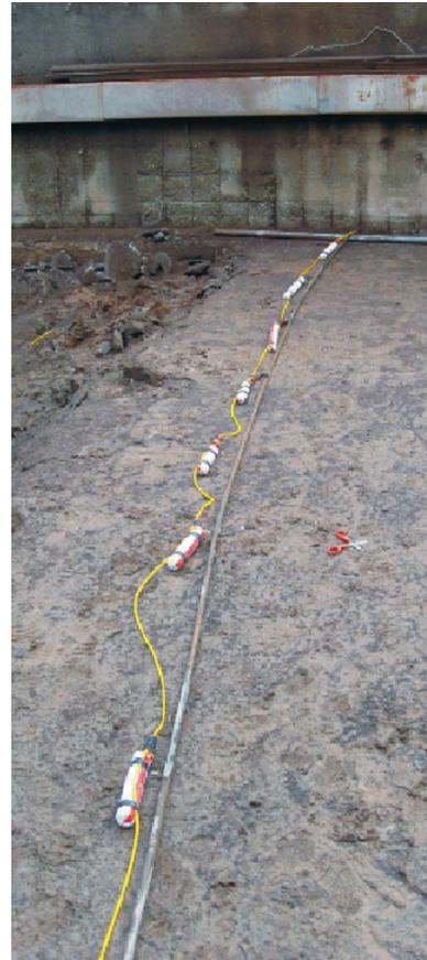
*Schema di caricamento di un foro nel sistema di taglio Cushion Blasting.*
