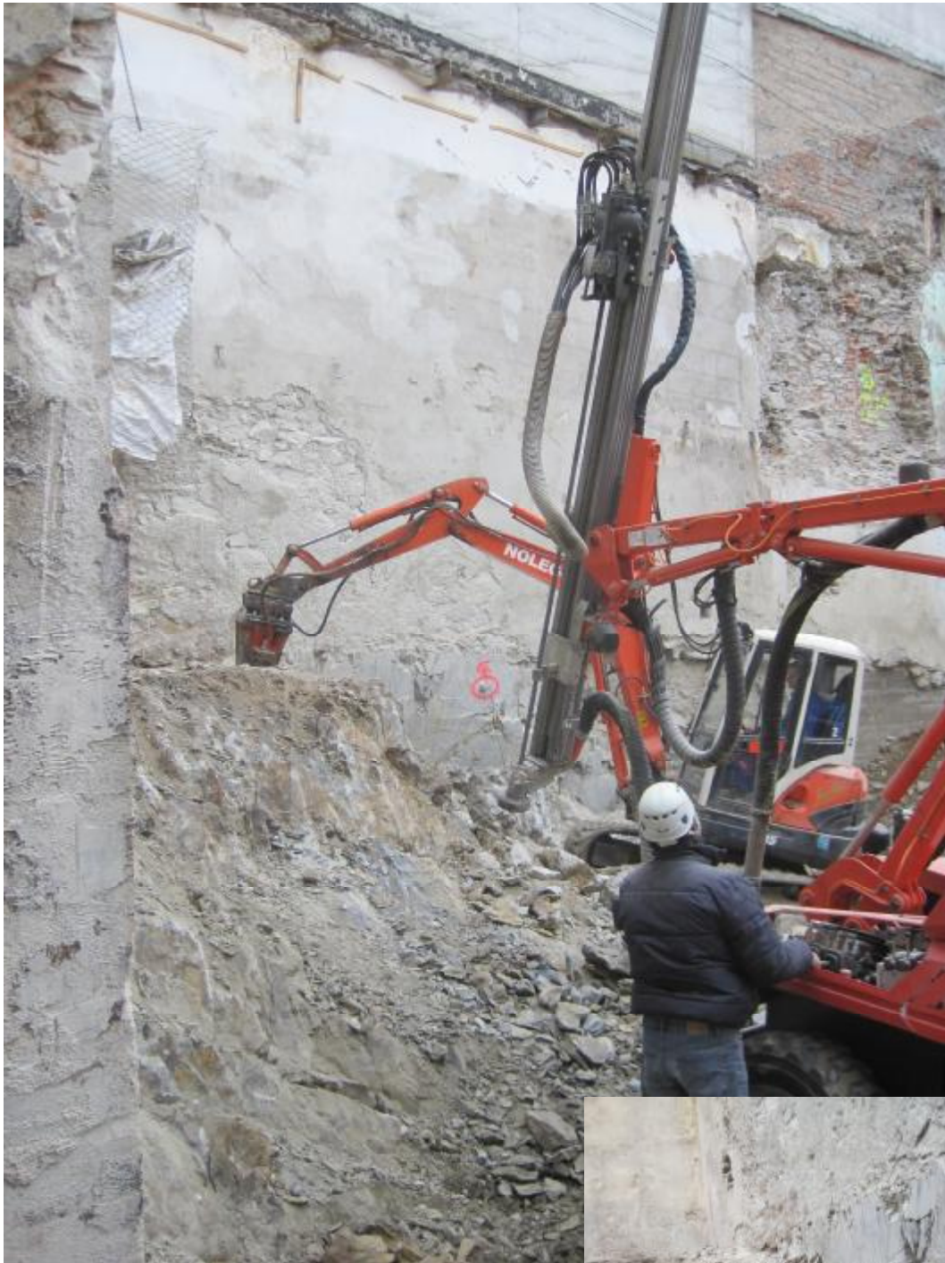
RIMOZIONE ROCCIA A MERANO Intervento di rimozione roccia alla base di un edificio del centro storico.
